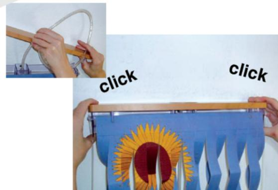
Holz Brettchen aufsetzen, indem Sie den Schlauch in der Mitte des o. Beckens durchstecken und anschliessend das Brettchen auf den Klammern festklicken. Nach dem Einrasten sollte sich das Poster noch leicht (1 - 2 mm) seitlich unter den Kunststoffhaltern schieben lassen.
